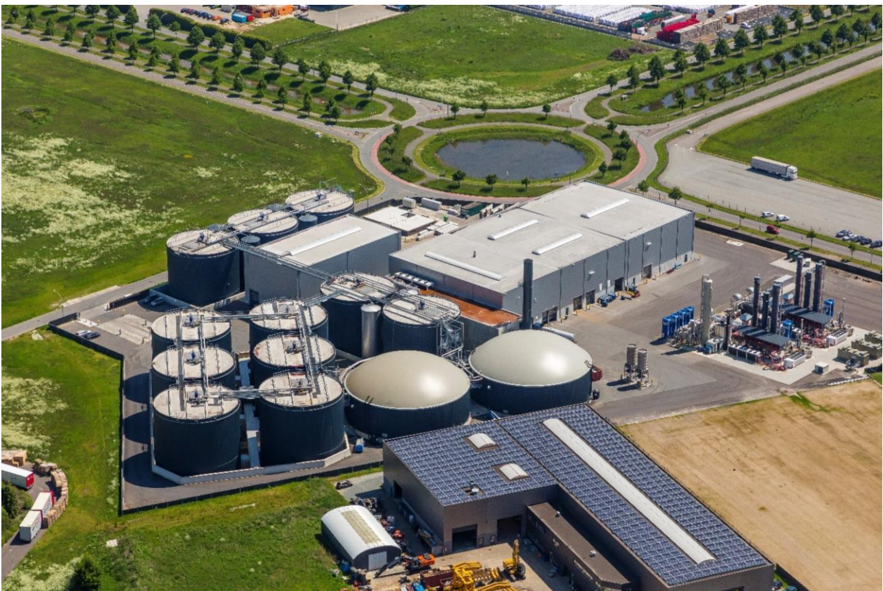
Figuur 1-1 Overzichtsfoto Bio Energy Coevorden BV (bestaande situatie 2021)
