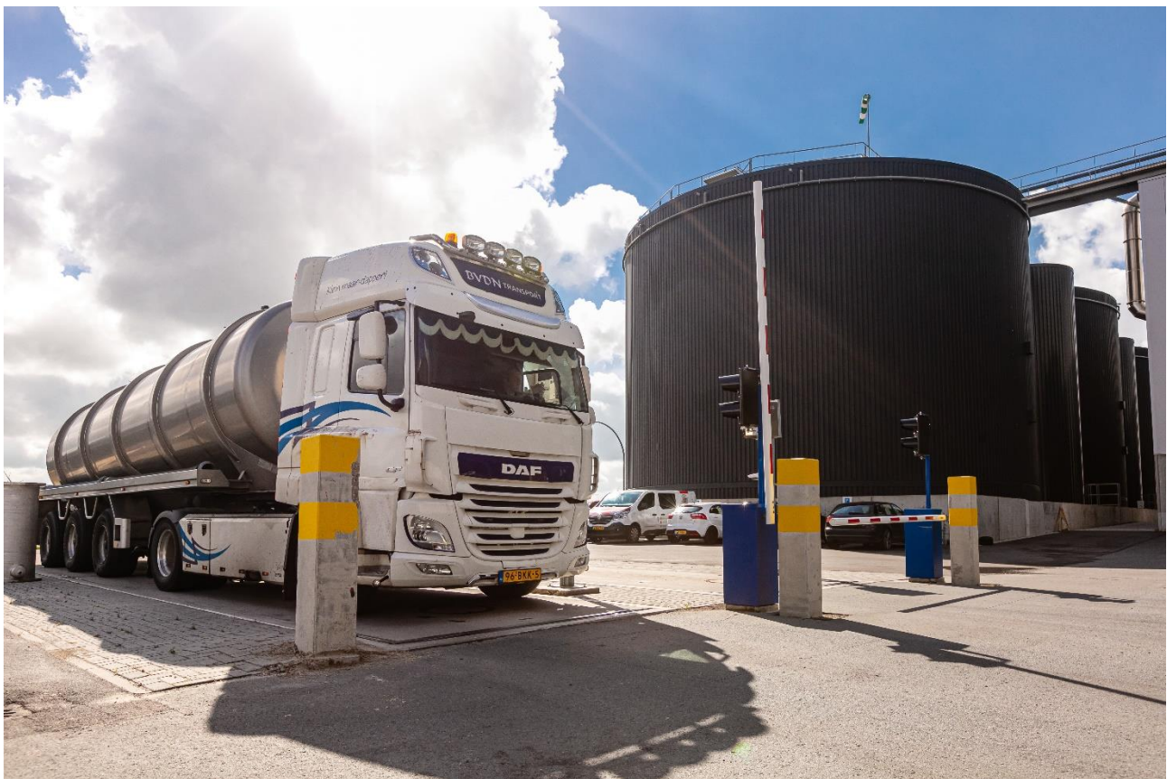
Figuur 3-2 Weegbrug Bio Energy Coevorden (bestaande situatie BEC).
