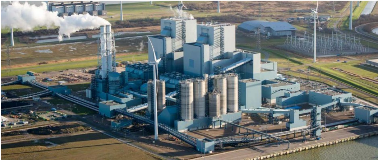
Figuur 3-1 Luchtfoto Eemshavencentrale
