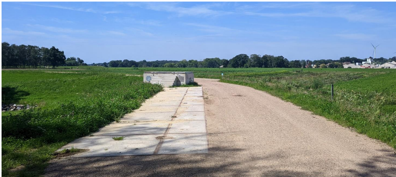
Figuur 30: Voorbeeld van toegangskokers bij Beesel voor een kruising van de beek met de dijk, inclusief een pompopstelplaats.
