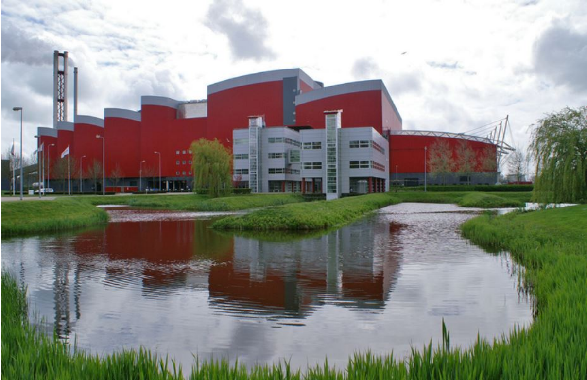
Afbeelding aanzicht HVC energiecentrale
