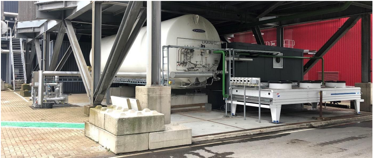
Figuur 9, rechts koelerbank voor de behuizing van de vervloeiing en de opslagtank ernaast (links)
