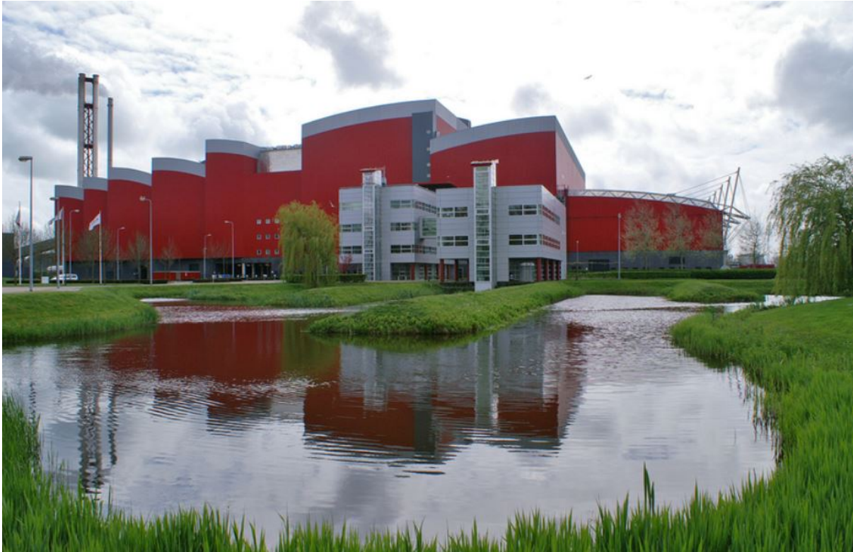
Afbeelding aanzicht HVC energiecentrale
