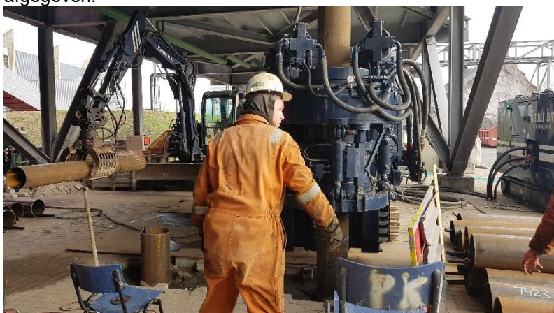
Figuur 5, heien van de fundering voor de opslagtank, februari 2019
