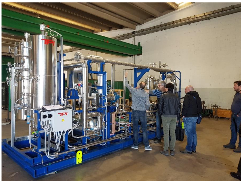
Figuur 7, Inspectie van de vervloeijingsinstallatie voorafgaand aan transport
