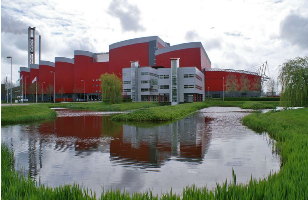
Afbeelding aanzicht HVC energiecentrale
