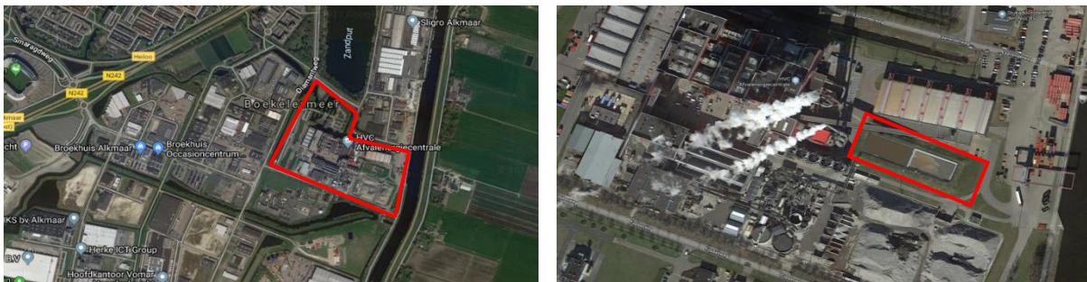
Figuur 5. Locatie van HVC (links) en locatie van installatie op de inrichting (rechts) aangegeven in rode kaders.
