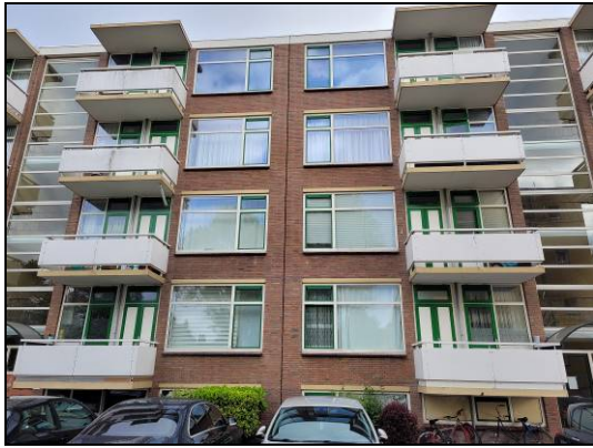
Afbeelding 6: Bebouwing met dilataties (Steenzicht)
