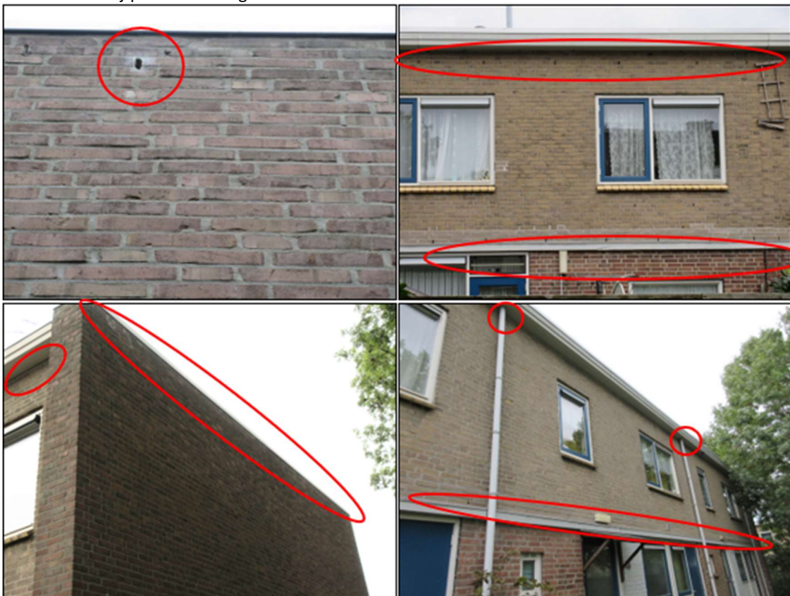
Figuur 2.4. Voorbeelden van voor vleermuizen geschikte openingen binnen het plangebied.
