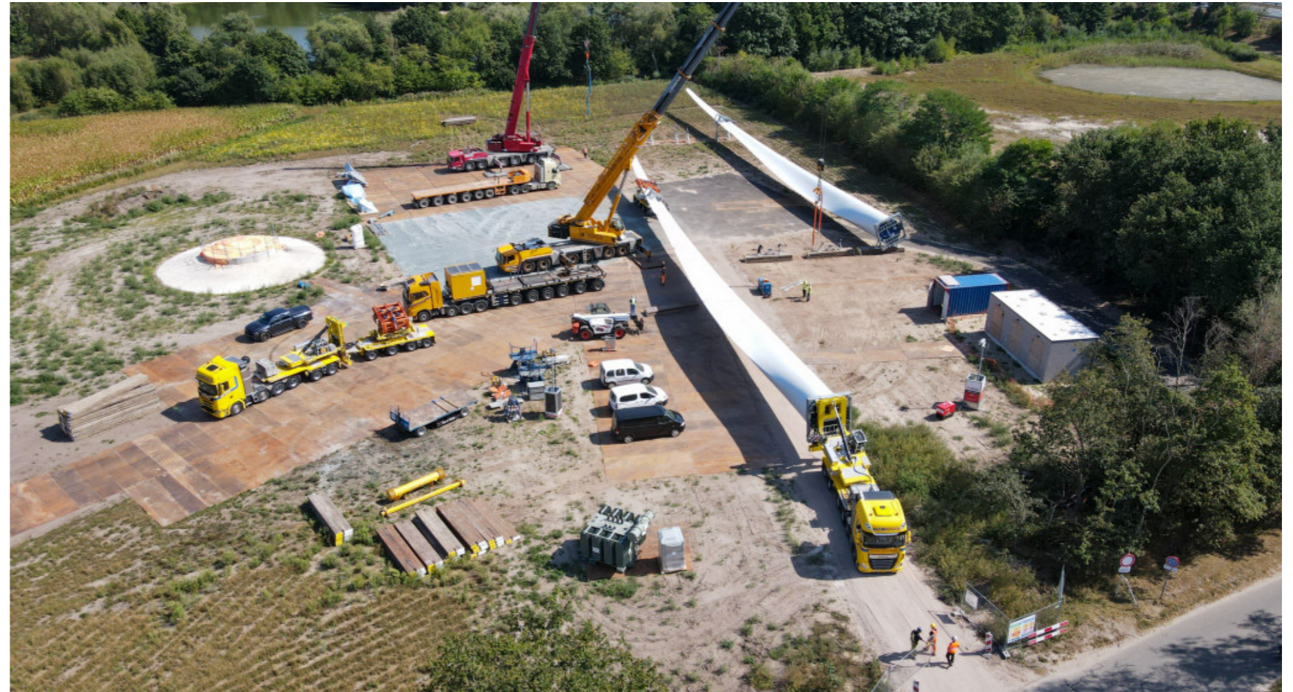
Constructiefase van een windturbine met een tiphoogte van 209 meter, een ashoogte van 135 en een rotordiameter van 149 m. Bron: Windpark Zonzeel, Noord-Brabant, (2023).
