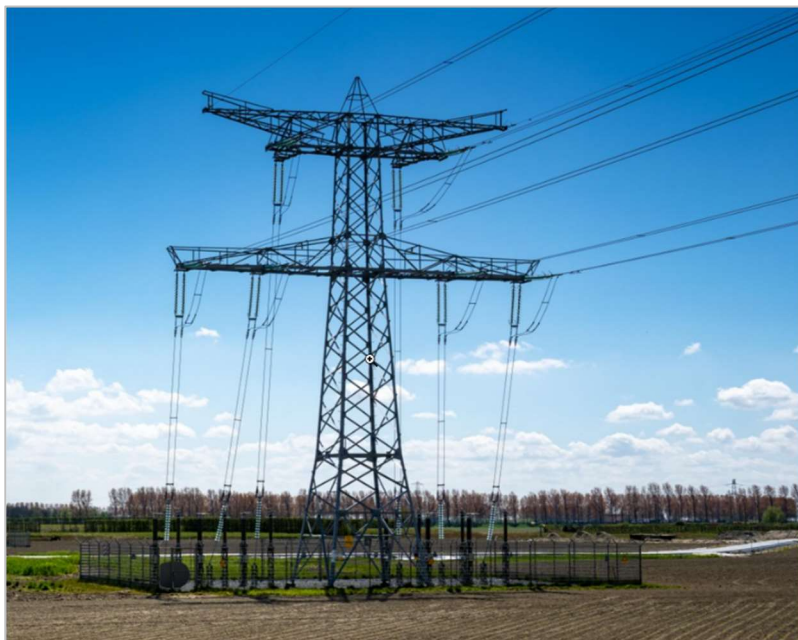
Figuur 1.14 Voorbeeld van een opstijgpunt onder een mast
