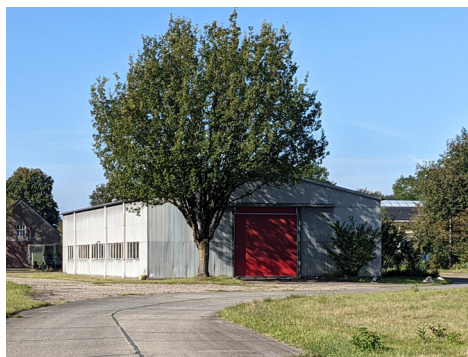
Gebouw 43 Periode (bouwjaar): Werkplaats (1969) Oorspronkelijke functie: brandweergarage/ stalling
