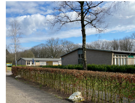
Gebouw 96 Periode (bouwjaar): Werkplaats (1967) Oorspronkelijke functie: bureelgebouw
