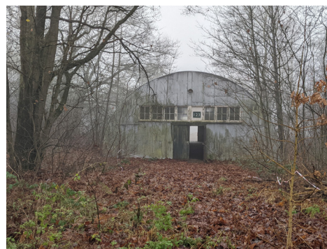
Gebouw 123 Periode (bouwjaar): Werkplaats (ca. 1950) Oorspronkelijke functie: magazijn
