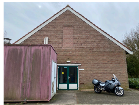
Kopgevel met dichtgezette venters zolderverdieping
