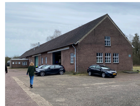
Grote openingen in noordgevel
