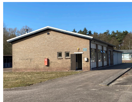
Gebouw 21 Periode (bouwjaar): Werkplaats (1955) Oorspronkelijke functie: was-, kleed en wapenherstel
