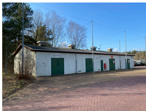
Gebouw 23 Periode (bouwjaar): Werkplaats (1955) Oorspronkelijke functie: magazijn/berging explosieven
