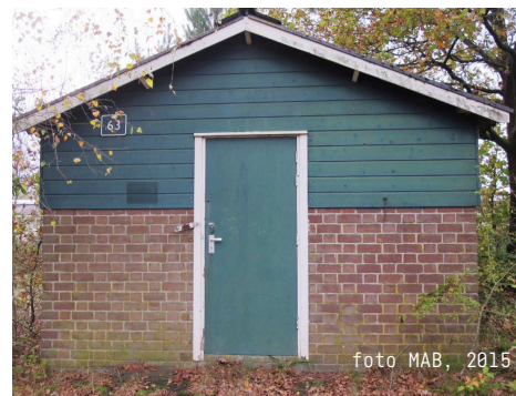
Gebouw 63 Periode (bouwjaar): Werkplaats (ca. 1950) Oorspronkelijke functie: magazijn
