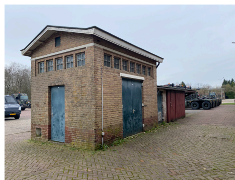
Berging met fietsenstalling nr. 83
