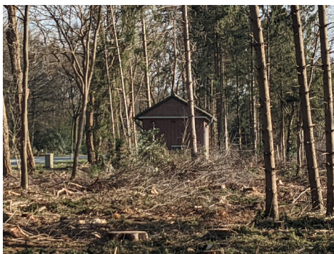
Gebouw 13 Periode (bouwjaar): Werkplaats (1952) Oorspronkelijke functie: trafostation
