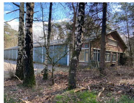
Gebouw 145 Periode (bouwjaar): Werkplaats (ca. 1951) Oorspronkelijke functie: magazijn
