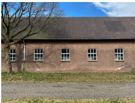
Zuidgevel met oorspronkelijke vensters
