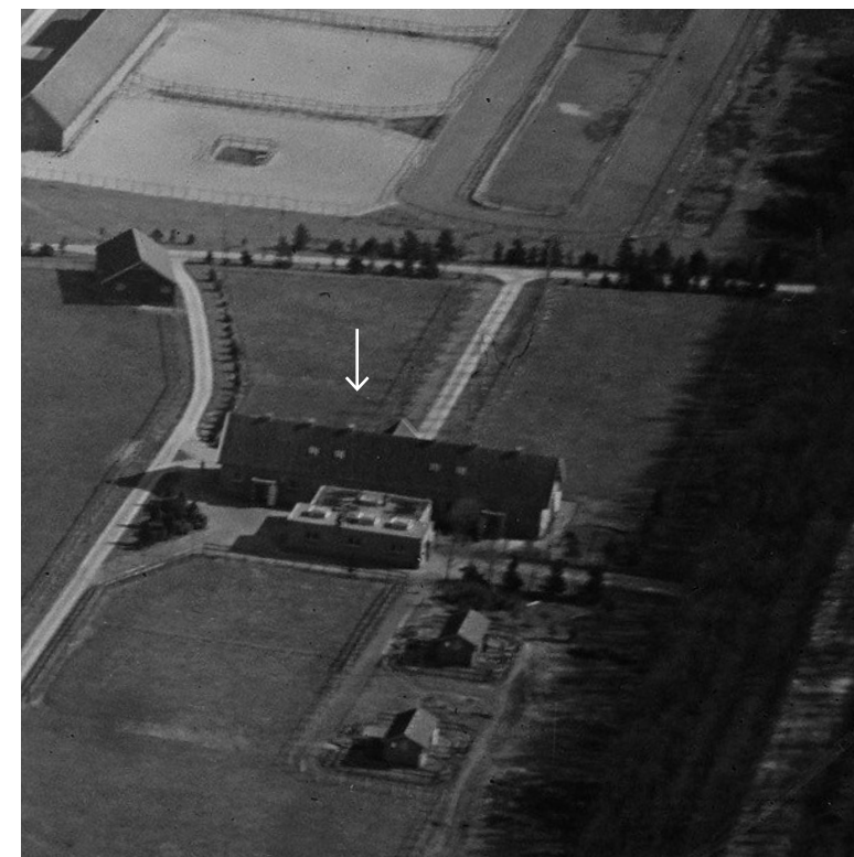
Fragment van de luchtfoto van het remonedepot, ca. 1930. Met een pijl aangewezen is gebouw nr. 84. [NIMH nr. 2011-0765]
