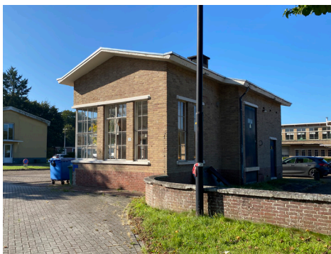
Portiershuisje met trafogebouw nr. 81
