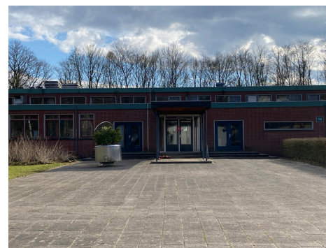
Gebouw 98 Periode (bouwjaar): Werkplaats (1965) Oorspronkelijke functie: keuken/eetzaal Aanpassingen: groot onderhoud in 1986
