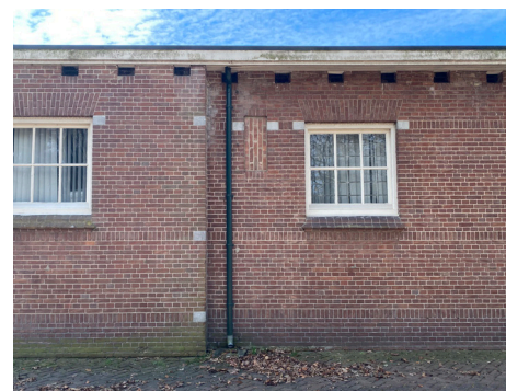
Metselwerkdetails en oorspronkelijke vensters
