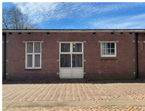
Oostgevel met voormalige hoofdentree
