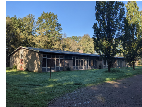
Gebouw 155 Periode (bouwjaar): Werkplaats (1967) Oorspronkelijke functie: bureelgebouw
