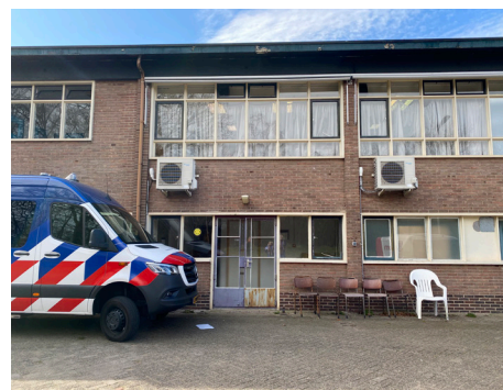
Oostgevel met toegangen tot het souterrain
