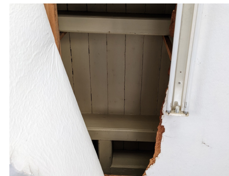
Oorspronkelijke afwerking achter verlaagd plafond
