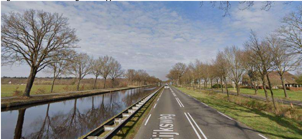
Figuur 6.2 Provinciale weg N371 Meppel-Havelte
