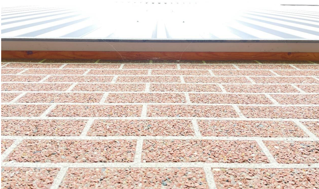
Foto 25: De afwerking van de stenenborstwing in de gevelplaten van de nieuwe stallen sluiten goed aan.
