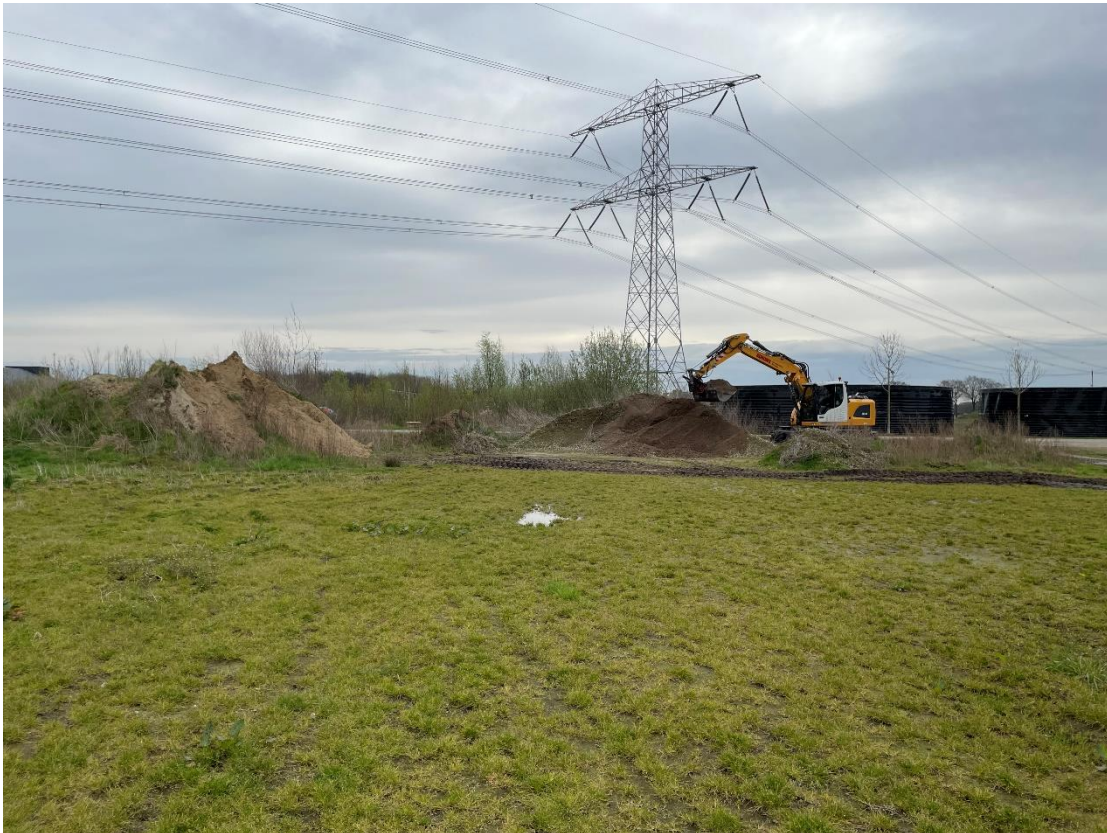
Foto 19: graafwerkzaamheden nabij deellocatie 3
