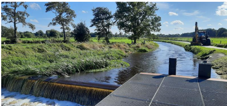
Afbeelding 2.10 Eekhoornsche Loop. Rechts in de oever is de duiker (buis) naar de Koppeling te zien
