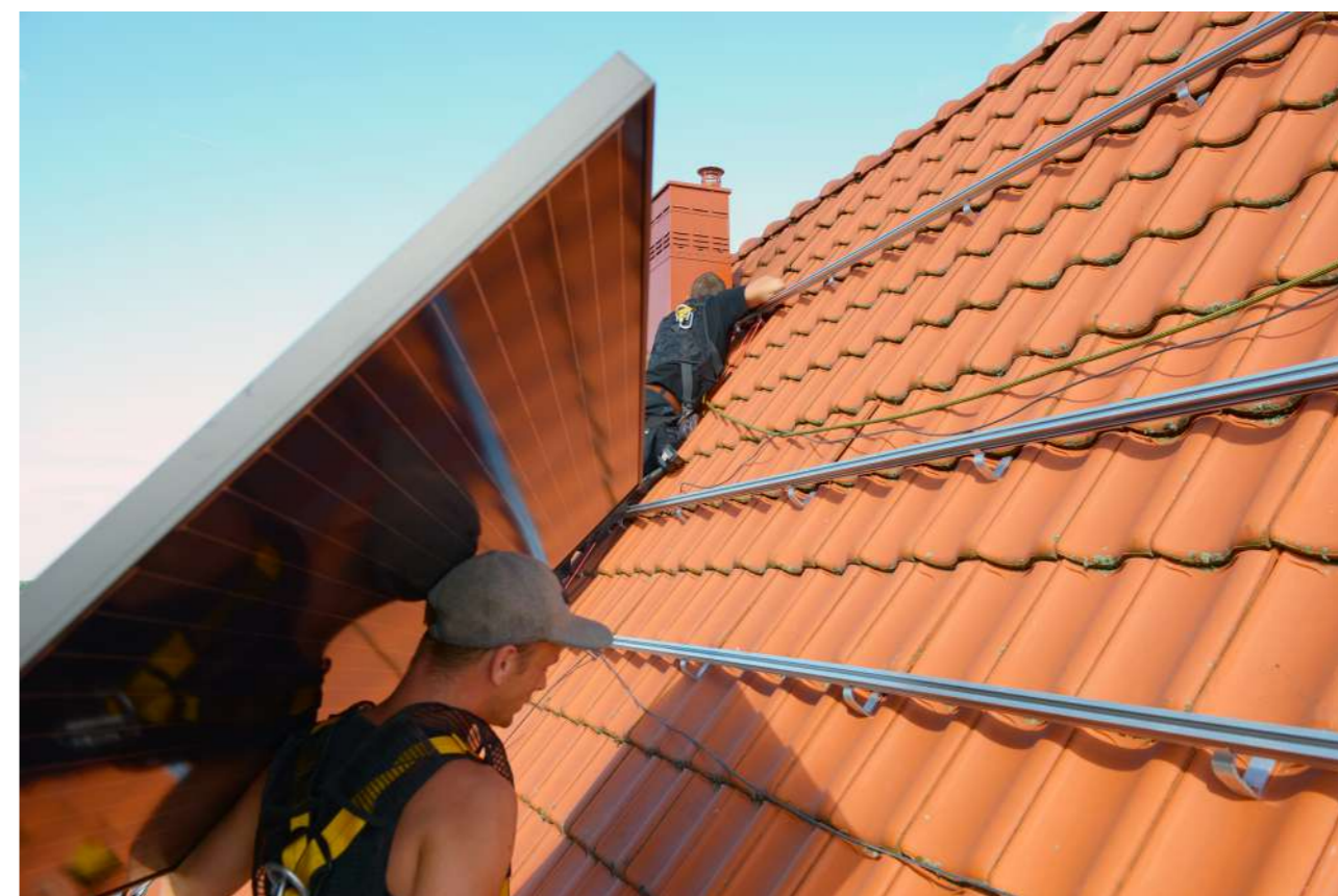
Aanbrengen zonnepanelen Westzaan
