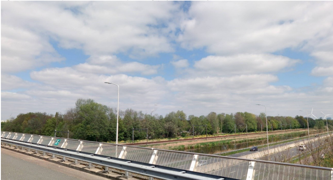
Figuur 43 Zichtpunt 1, onderzoekopstelling 1B (Brettenzone)
