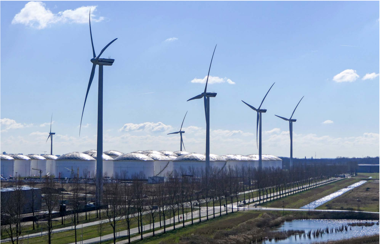
Windturbines in bij de Afrikahaven in het Havengebied Amsterdam Westpoort.
