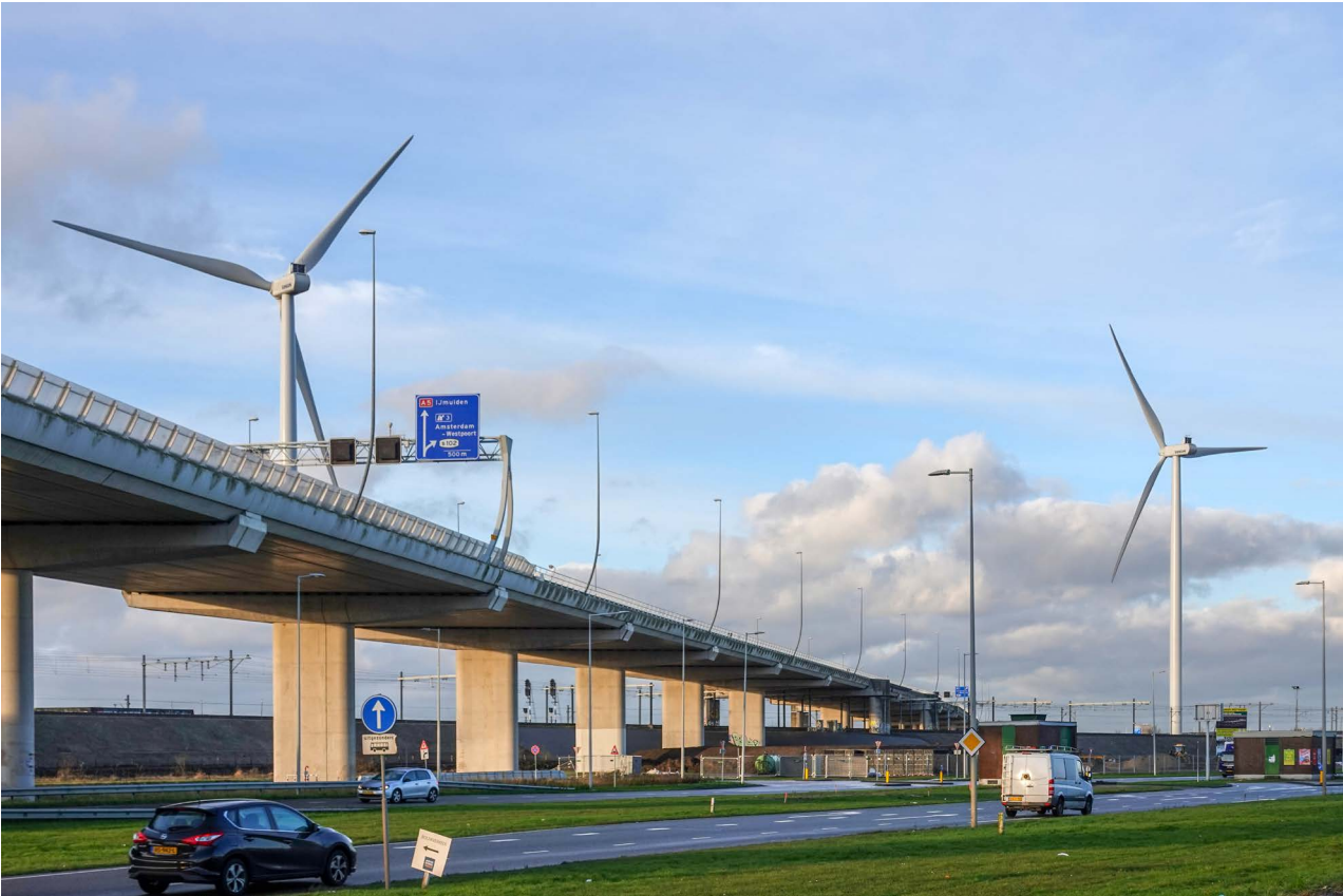
Windturbines bij de Basisweg in het Havengebied Amsterdam Westpoort.
