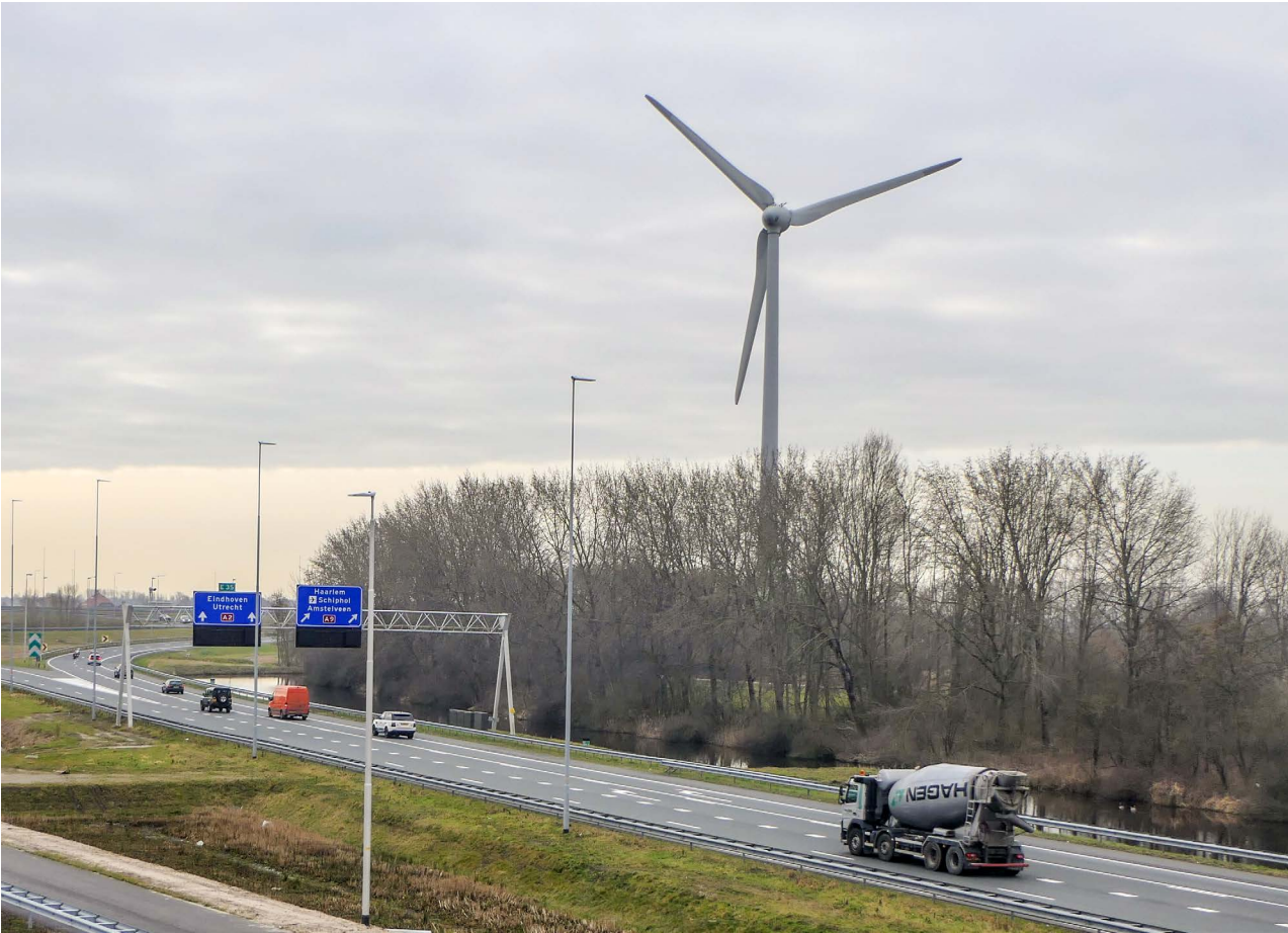
Bestaande windturbine Amstelvogel op grondgebied van gemeente Ouder-Amstel nabij knooppunt Holendrecht. In coöperatief beheer.
