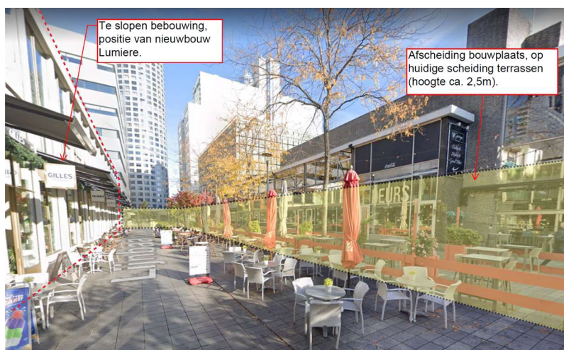
Figuur: afscheiding van de bouwplaats op de Lijnbaan gezien vanaf de bouwplaats
