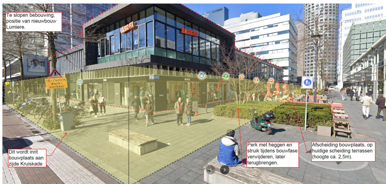
Figuur 3.1: Afscheiding bouwplaats op hoek Kruiskade - Lijnbaan
