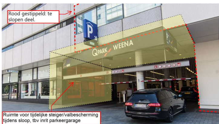
Figuur 3.3: Tijdelijke maatregel tbv sloop bouwdeel boven inrit parkeergarage Q-Park Weena
