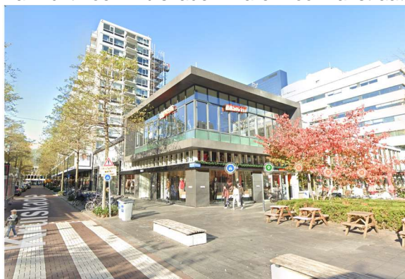
Aanzicht hoek Kruiskade – Lijnbaan (rechts) Lijnbaan
