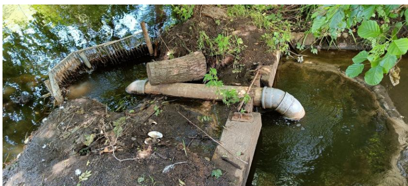
Figuur 2-8: overlaat aan de zuidzijde van de visvijver Tangkoel
