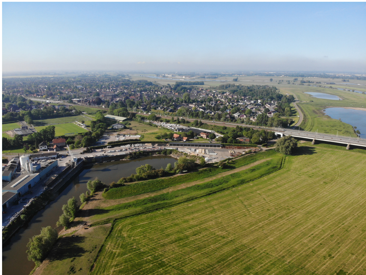
Zicht op het buitendijks gelegen Struyck Verwo, de spoorbrug en daarachter het dorpsfront van Westervoort met de Mosterdhof
