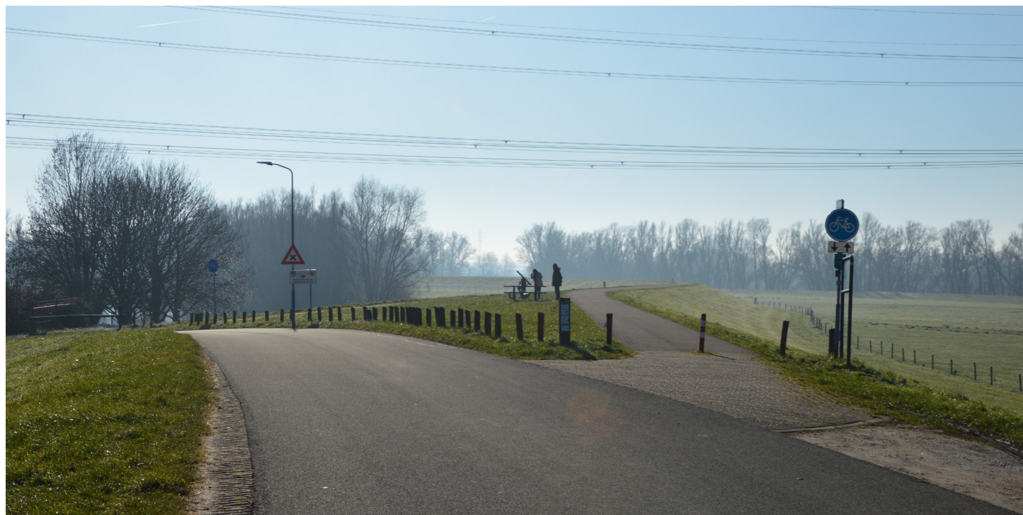
Dijkknoop van de historische dijk van Loo met de planmatige dijk van het Pannerdensch Kanaal
