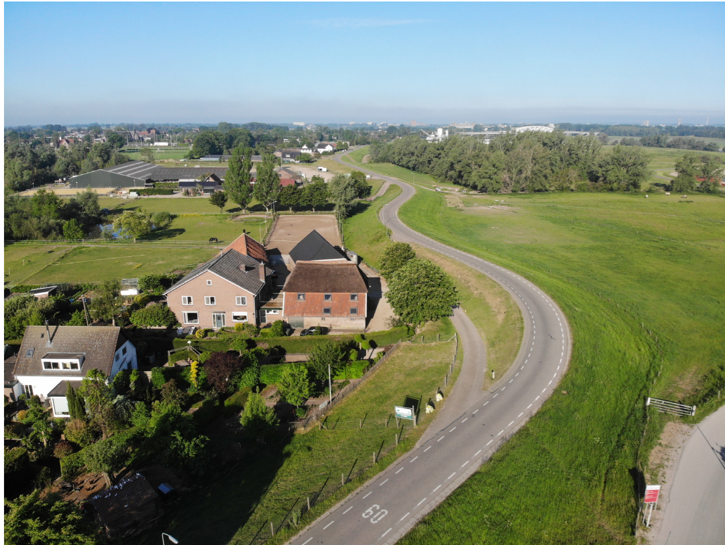
De IJsseldijk ter hoogte van de manege en Putman Recycling buitendijks
