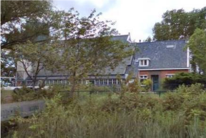
Figuur 8: Pand Damsterweg 4 (Delfzijl/Libau 2020)
