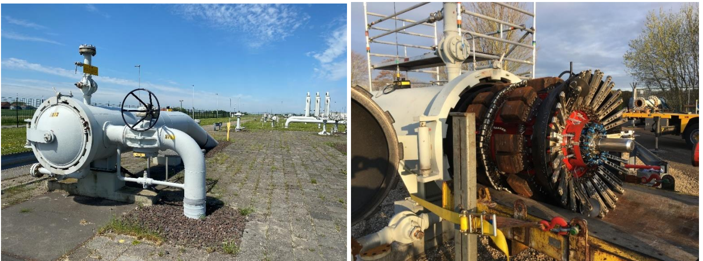
Figuur 3-3 Voorbeeld van pigfaciliteit (links). Bovengronds kan de pig worden ingebracht en wordt via de pigfaciliteit naar de ondergrondse leiding geleid. Rechts wordt het inbrengen van een pig weergegeven.
