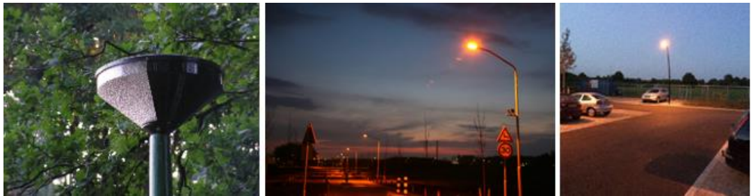
Figuur 6.9 Voorbeeld straatlantaarn met afschermkap (links) en amberkleurige verlichting gericht op verharding (midden en rechts). Bron foto's: Zoogdierverseniging en Rijkswaterstaat.
