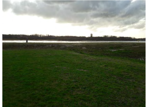
Fotonummer: 2 Omschrijving: Het tracé op de kruising van het Hartelkanaal en de Oude Maas. Kijkrichting: zuid.
