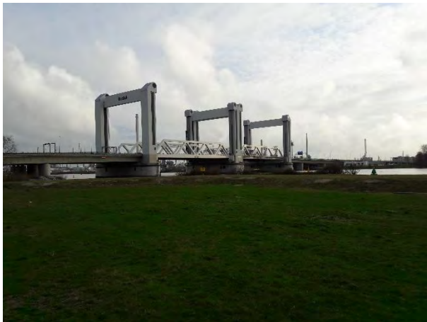
Fotonummer: 3 Omschrijving: Het tracé op de kruising van het Hartelkanaal en de Oude Maas. Kijkrichting: noordoost.
