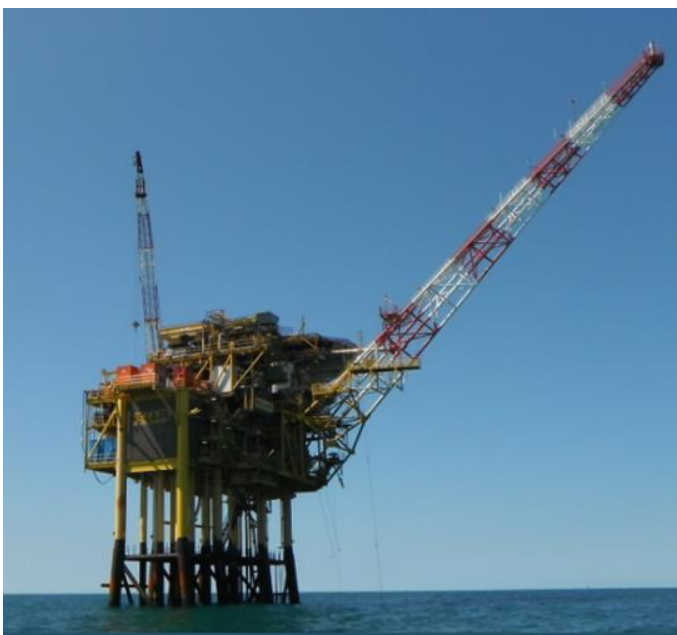
Figuur 3-1: Foto van het platform met de huidige gasproductie installatie
