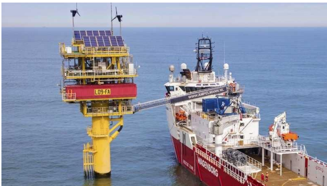
Figuur 4-4 Windturbines en zonnepanelen op een normaal onbemand platform in de Nederlandse offshore met een W2W schip.
