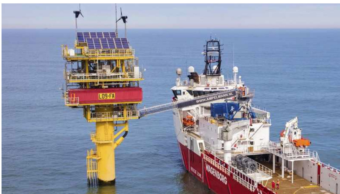
Figuur 9-2: Windturbines en zonnepanelen op een normaal onbemand platform met een onderhouds- en inspectieschip.
