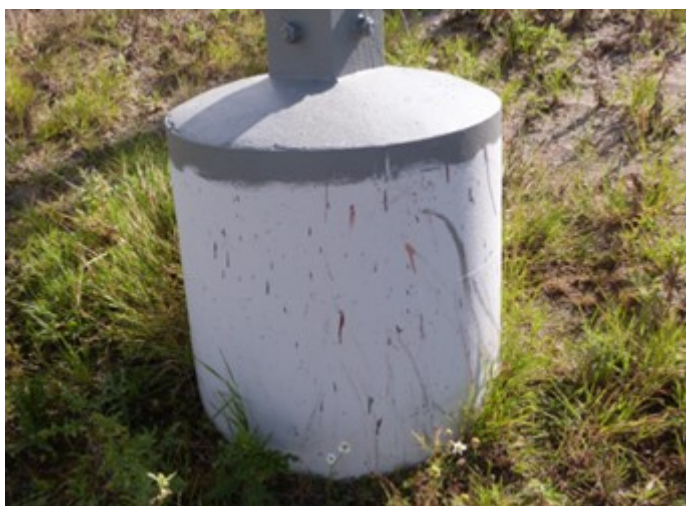
Figuur 1.15 Een voorbeeld van de verharding boven maaiveld van een mastvoet, bij een met beton gevulde stalen buispaal
