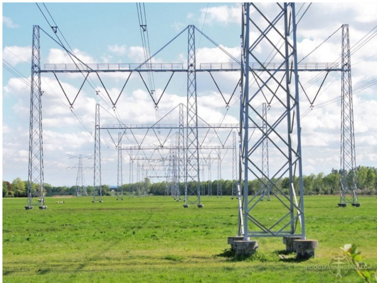
Figuur 8.2 Foto van portalen. Bron: hoogspanningsnet.com
