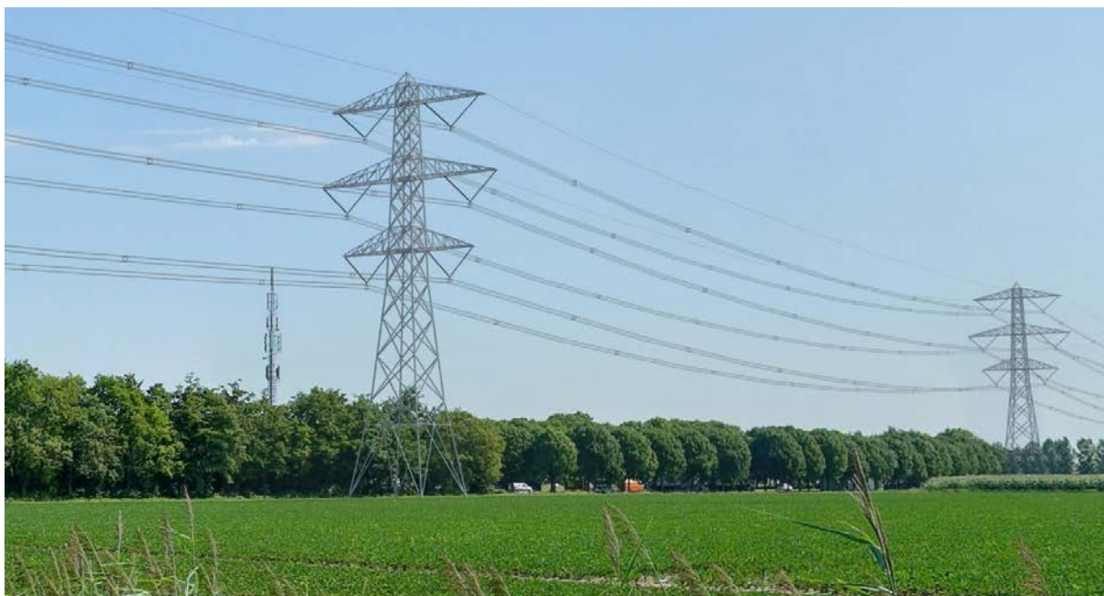
Figuur 1.14 Visualisatie van een Moldau mast in het landschap (bron: projectatlas Zuid-West 380kV-oost)
