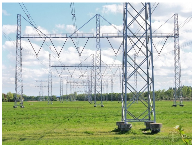
Figuur 8.2 Foto van portalen. Bron: hoogspanningsnet.com
