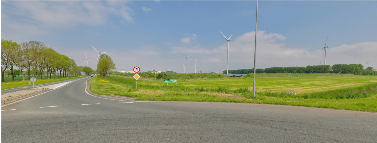
Figuur 3-6 Huidige situatie gezien vanaf straatniveau (bron: Projectatlas TenneT)
