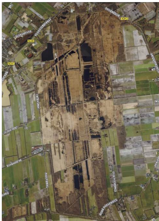
Figuur 3.1. Luchtfoto met daarop zichtbaar de bestaande compartimentering (bron: StreetSmart, 2022)
