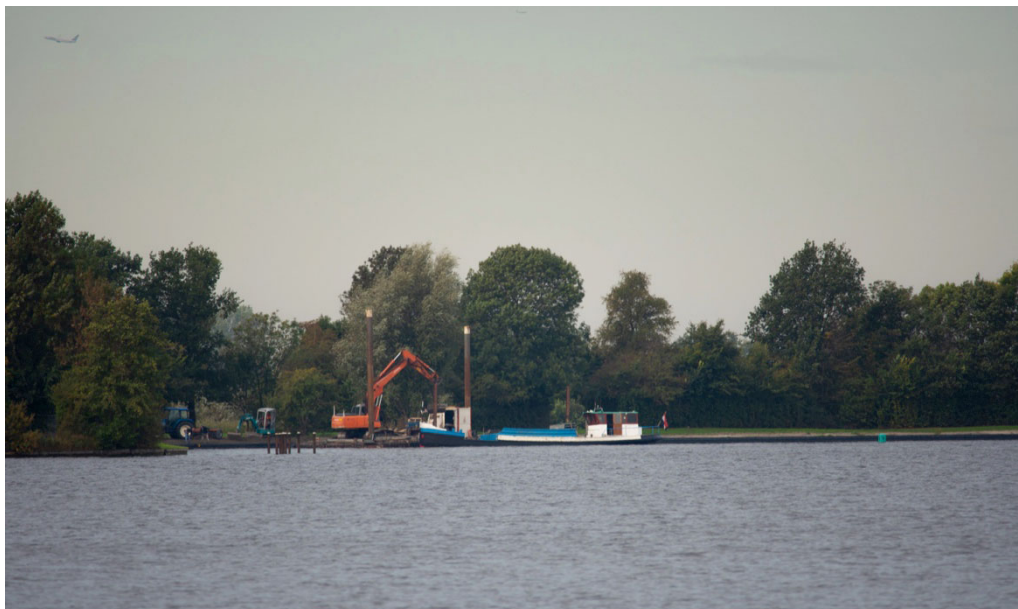
Figuur 2.7 Plaatsen van nieuwe beschoeiingen langs de zandeilanden.
