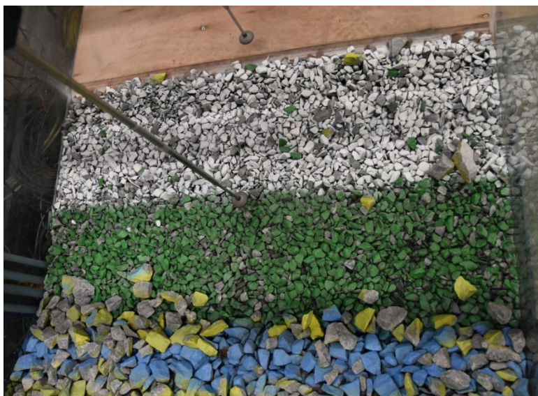
Figuur 5-24: Foto van schade aan 1-50 kg achter de langsdam na T310 (bovenaanzicht)
