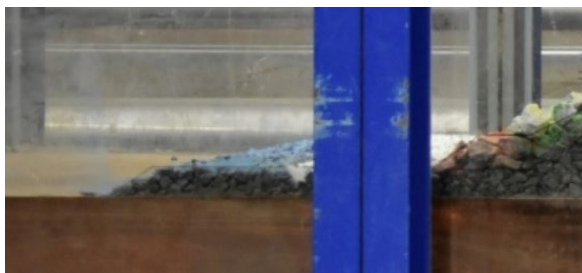
Figuur 5-27: Foto van schade aan 1-50 kg voor de teen van de langsdam na T310 (zijaanzicht)
