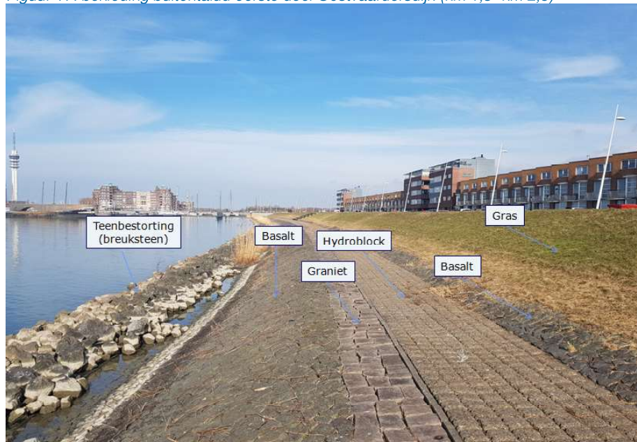
Figuur 17: bekleding buitentalud eerste deel Oostvaardersdijk (km 1,3- km 2,8)
