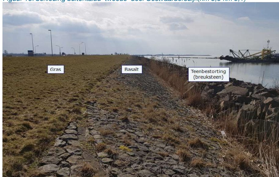
Figuur 18: bekleding buitentalud tweede deel Oostvaardersdijk(km 3,8-km 5,1)
