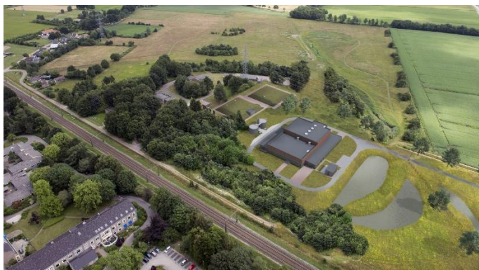
Figuur 49 Luchtfoto van de Productielocatie Drinkwaterwinning Beilen (WMD)
