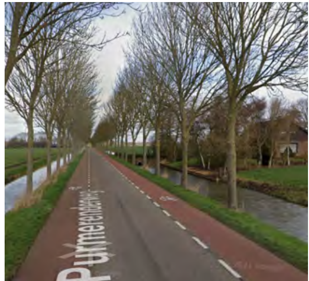
Purmerenderweg in het noorden - hoge snelheden, geen vrijliggend fietspad
