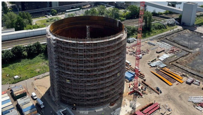
Afbeelding 2.11 Bovengrondse warmteopslagtank onder constructie bij Reuter West te Berlijn (bron: Vattenfall, 2022)
