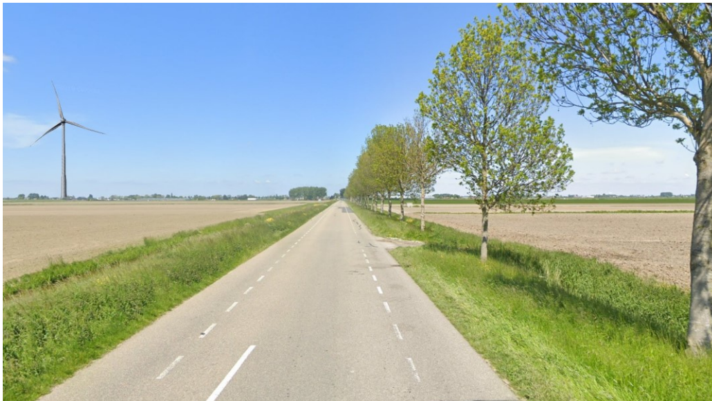
Afbeelding 5.23 De ruimtelijke inpassing van een 166 m windturbine (circa 20 GWh) in een akkerland (op circa 1,1 km afstand tot de windturbine)
