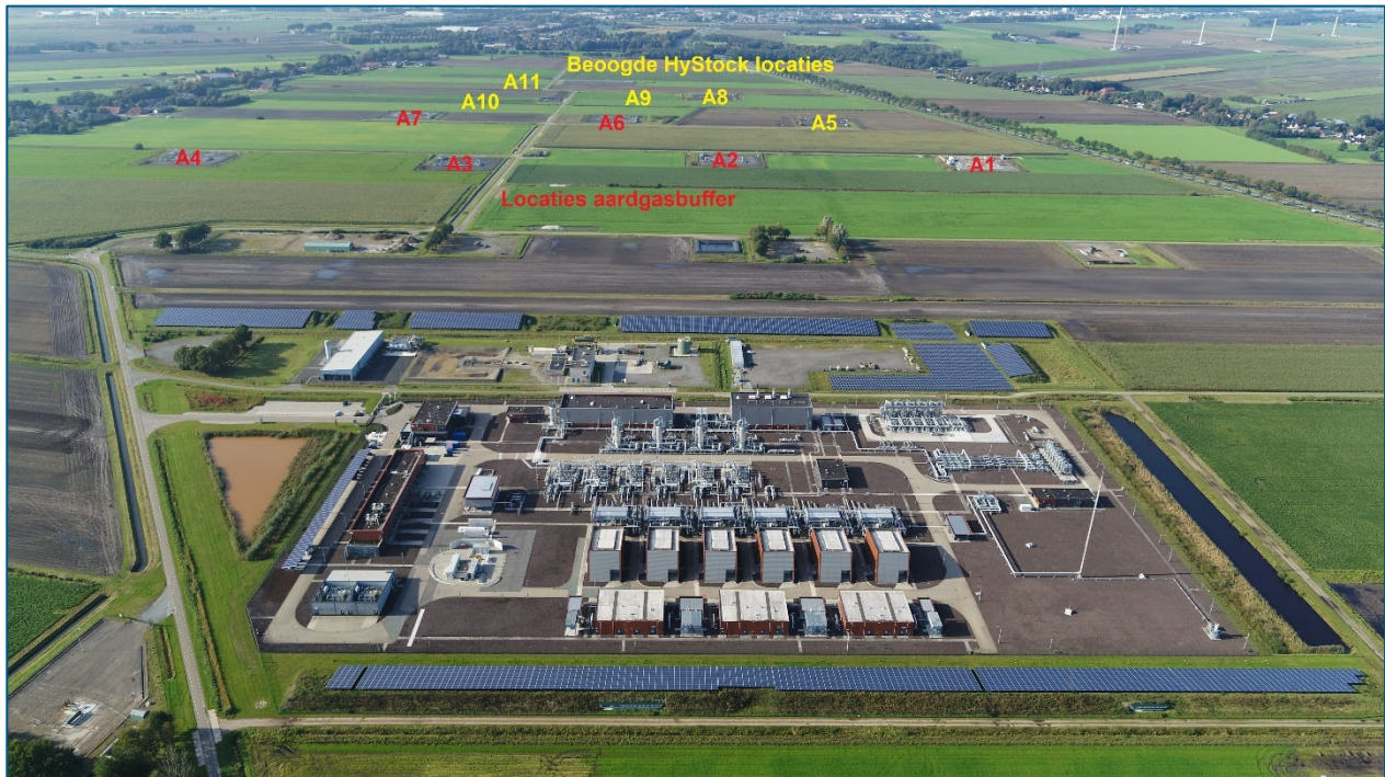
Figuur 4-2: Bestaande en beoogde zoutwinnings-/opslaglocaties aan het maaiveld (zicht in westelijke richting)
