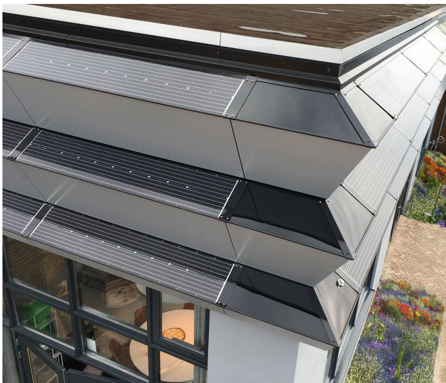
Figuur 8b Innovatie in PV aan de gevel. Gevelpanel reflecteren zonlicht op de PV panelen.
