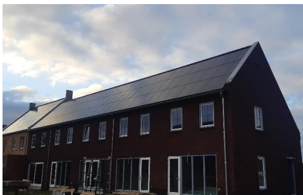
Figuur PVT panelen op een project in Chaam.
