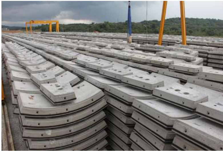
Figuur 2-12 Opslag tunnelsegmenten
