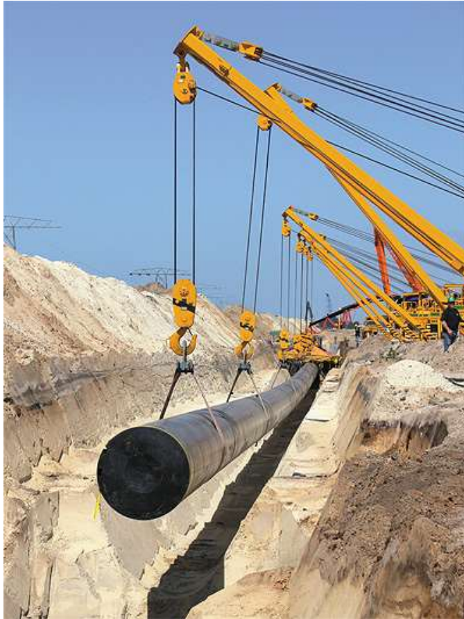
Figuur 2-18 Pijpleiding aanleg sleuf ontgraving (foto A. Hak)
