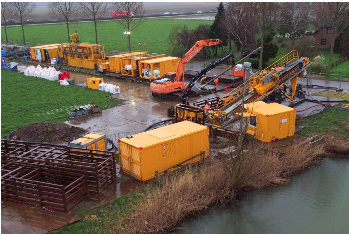
Figuur 3-8 Boorstelling (rig) voor de uitvoering van een horizontaal gestuurde boring.
