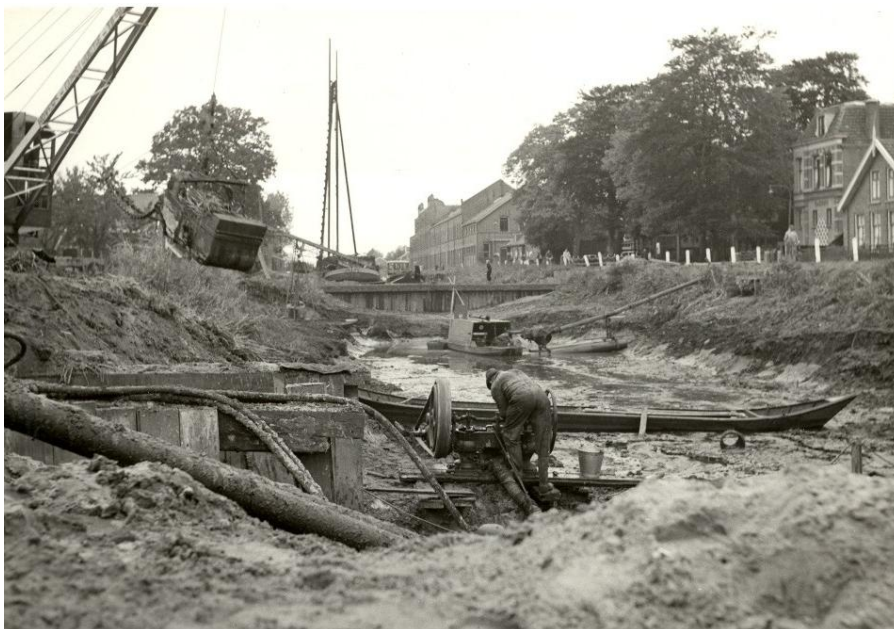
Figuur 3.4 Werkzaamheden aanleg kanaal nabij Vriezenveen. Bron: www.canonvannederland.nl
