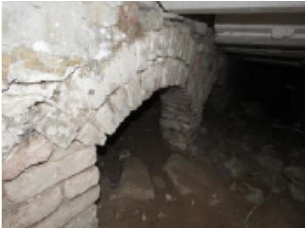
Figuur 3.28 Fundering op poeren met gemetselde bogen
