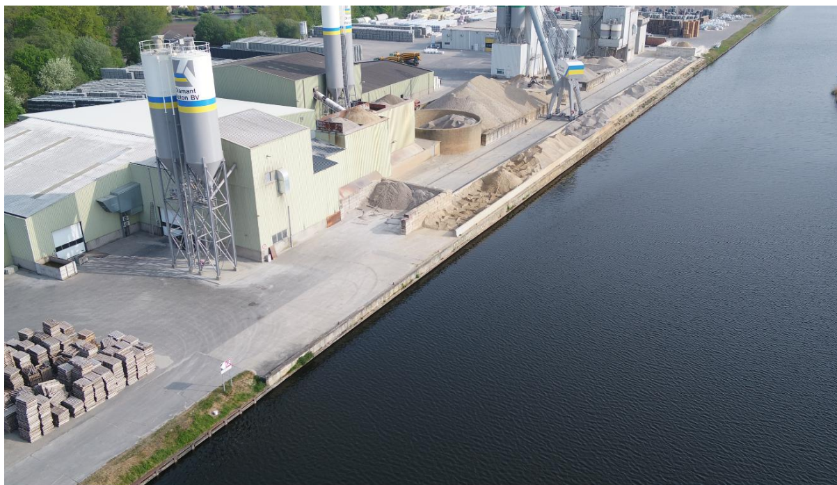
Figuur E.8. Kade met verankerde betonnen damwand bij betonfabriek Diamant
