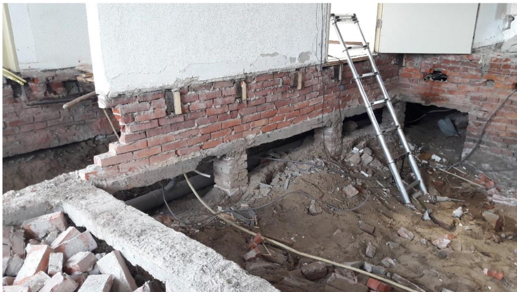
Figuur 3.29 Poerfundering met betonbalk over de poeren
