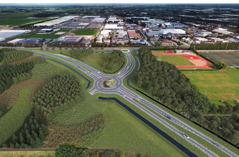
Rotondes sluiten aan op de Hoogeteenseweg
