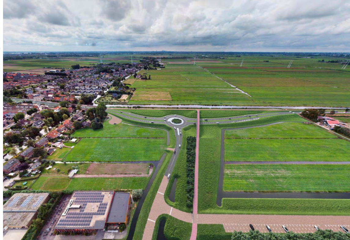
Bovenaanzicht rotonde noord en fietsviaduct Hazerswoude-Dorp
