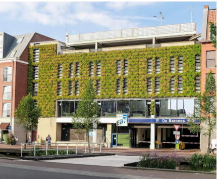
Parkeergarage Barones, Breda
