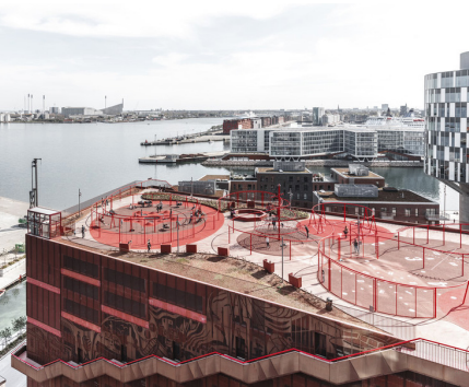
Parkeergebouw met sportveld, Copenhagen
