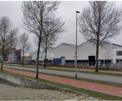
Voormalige Rijnparkstaalhallen in Rijnpark
