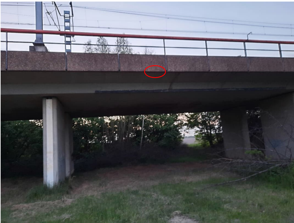
Figuur 4.6 (Tijdelijke) Rustplaats van een Myotis spec. (vermoedelijk meervleermuis) in de spoorbrug.
