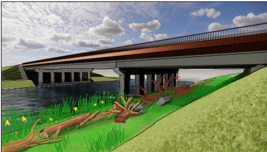
Figuur 3-3: Voorbeeld van stobbenwal onder de brug (Sweco, 2024).
