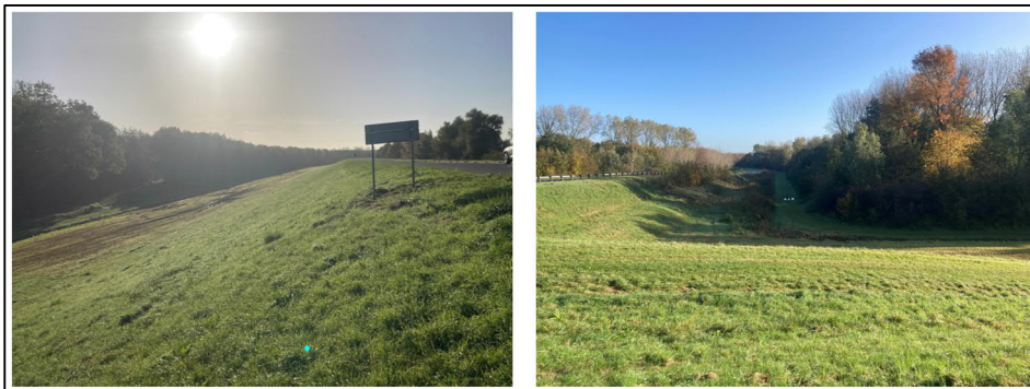
Figuur 3-14: Knardijk in de huidige staat. Links: aanzicht in zuidelijke richting. Rechts: aanzicht in noordelijke richting (Sweco 2024).
