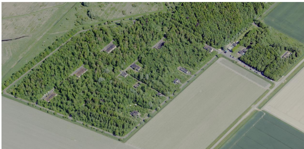
figuur 9-18: zicht op de locatie
