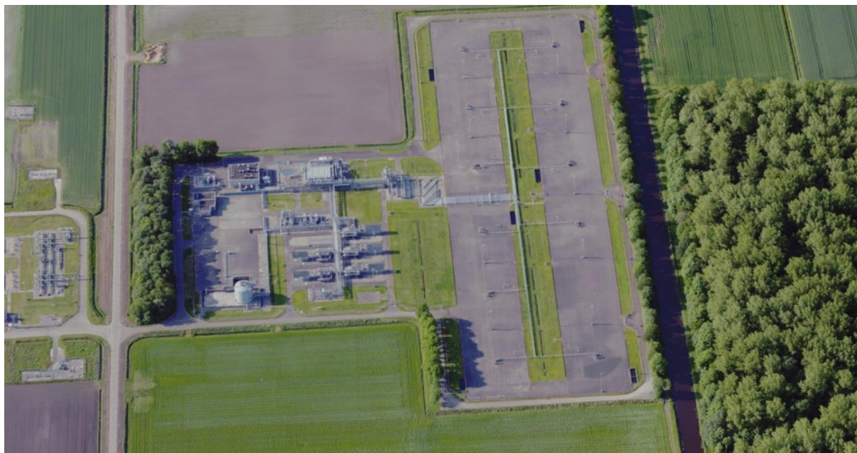
figuur 10-19: zicht op de locatie
