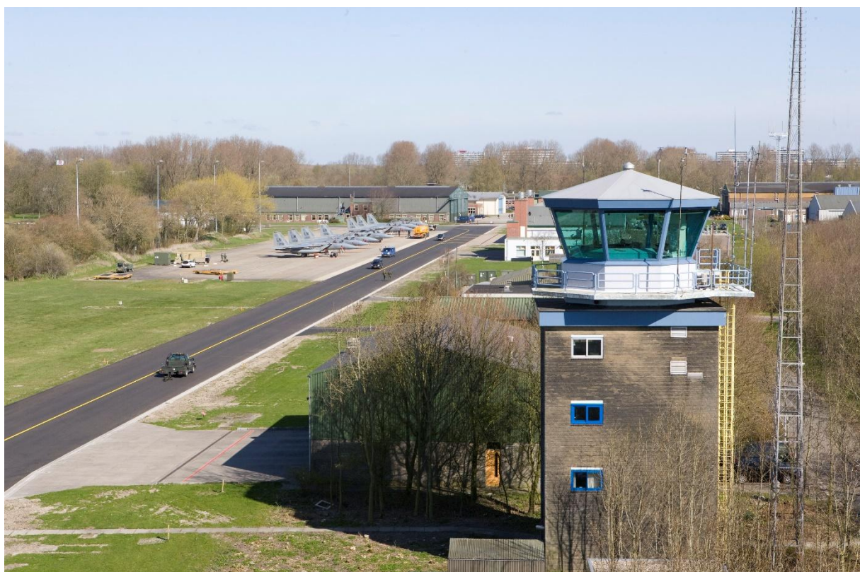
figuur 2-1 Foto van de verkeerstoren en jachtvliegtuigen op vliegbasis Leeuwarden
