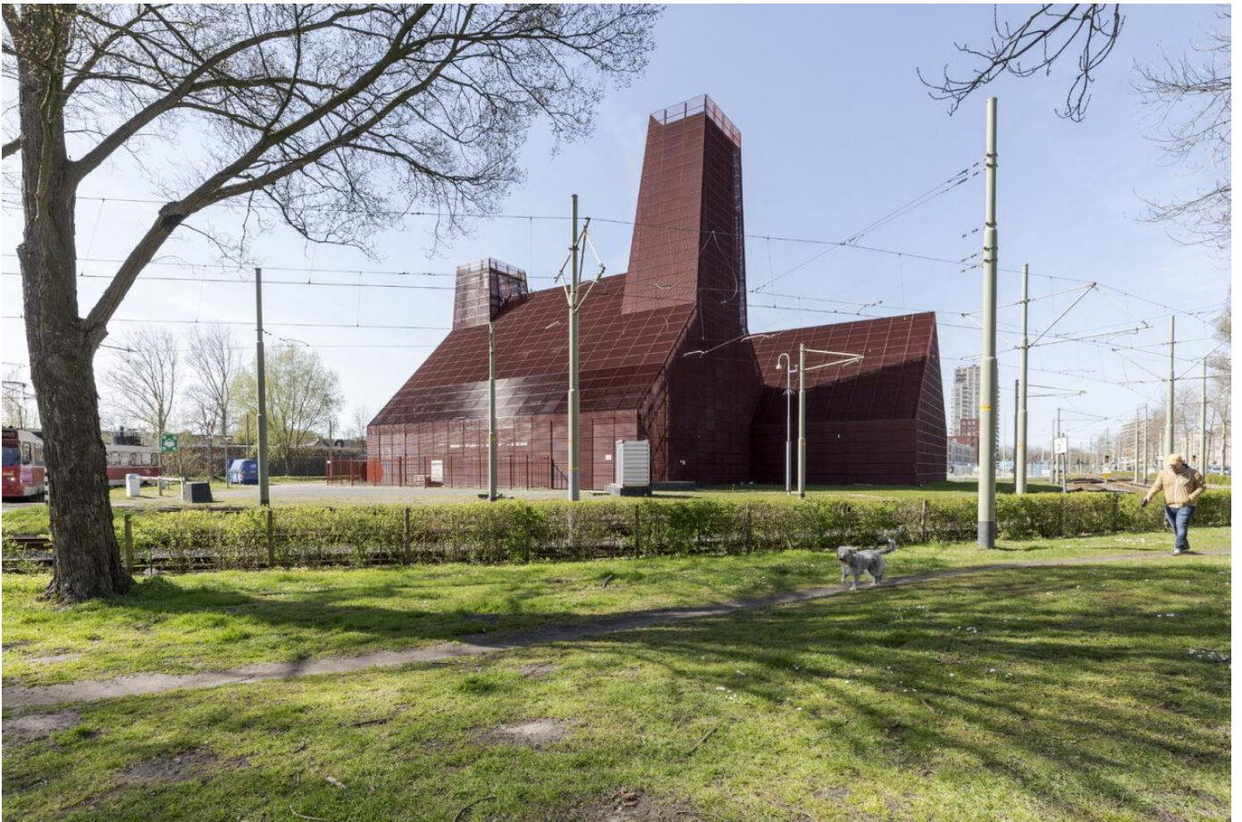
Foto: Geothermie locatie Leyweg
